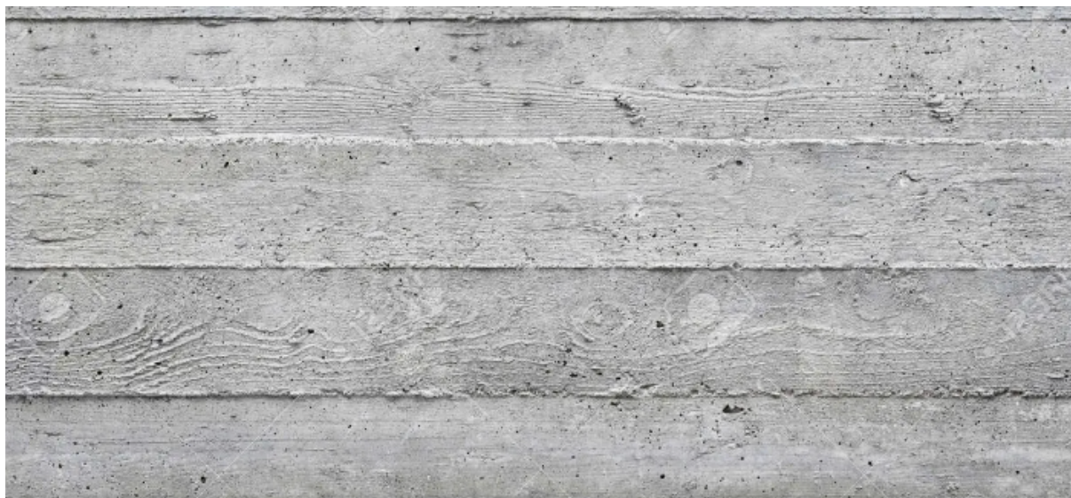
Obr. požadovaná výsledná textura spodního líce betonové desky.
