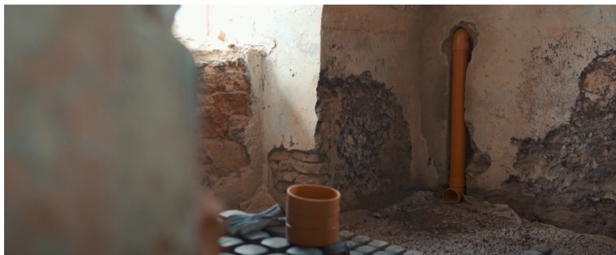
Obr. svislá rýha a osazená tvarovka PVC-KG
