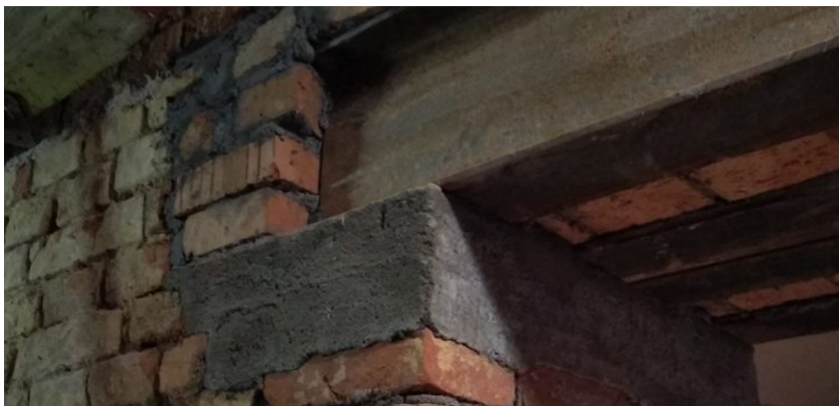
Obr. nově zhotovený překlad na betonovém roznášecím bločku
