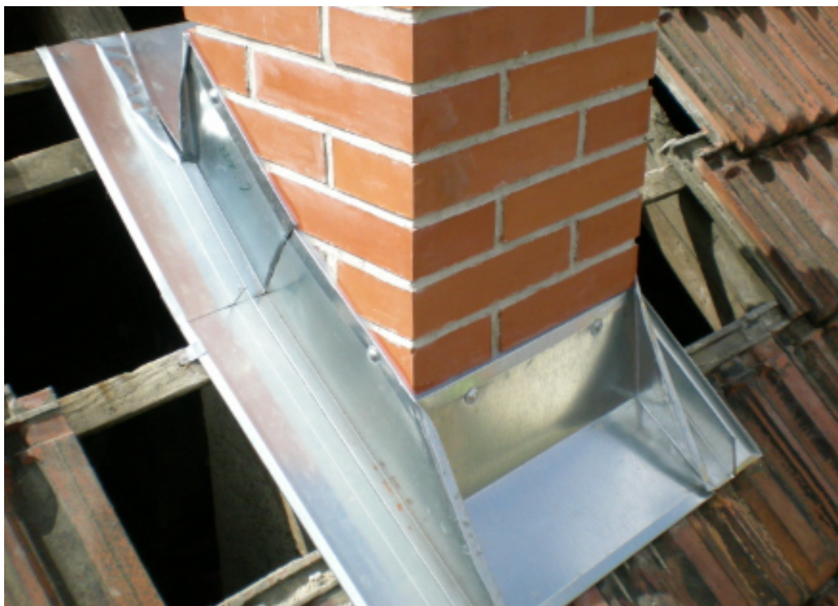
Obr. oplechování komína z pozinkovaného plechu
