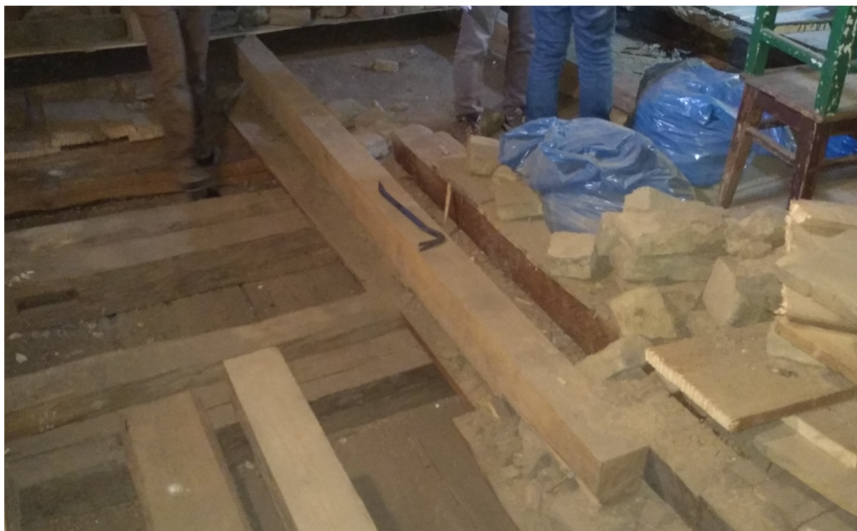
Obr. Sonda do stropu nad hlavní částí
