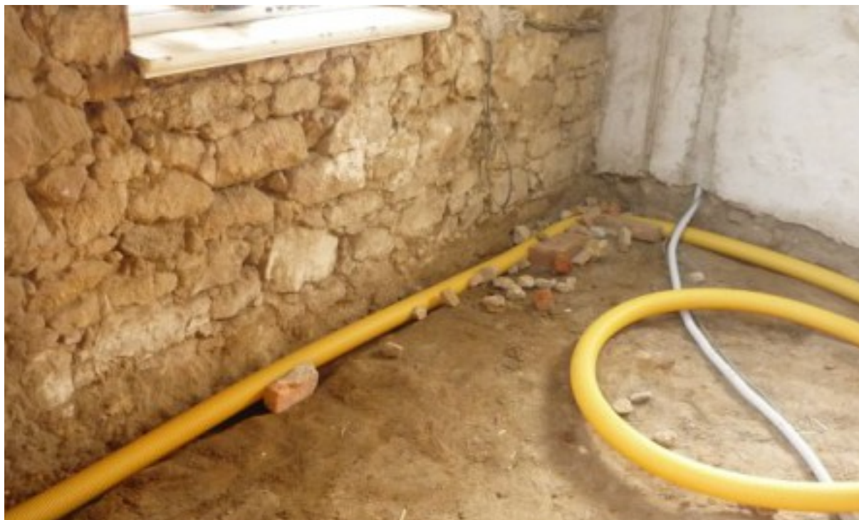
Obr. systém odvětrání podlahy
